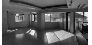
リフォーム前、開口が多く明るい既存建物
