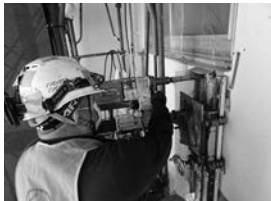
耐震スリット工事作業中
