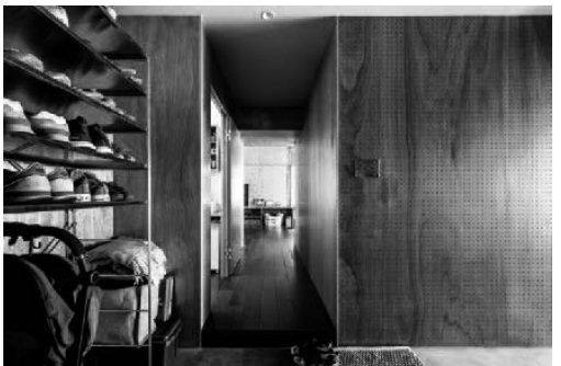
間仕切りは施主と製材所まで行き選んだラワン合板の化粧張り仕上げ
