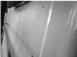
耐震スリット補強工事完了
