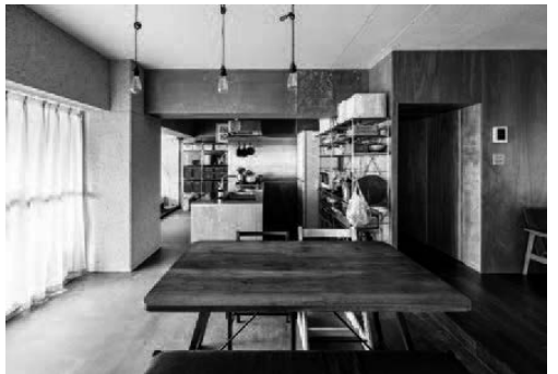
墨入りモルタルで仕上げた土間キッチン。リビングは草木染フローリング
