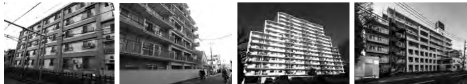
マンション耐震補強工事 施工例
