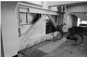
ブレース補強
