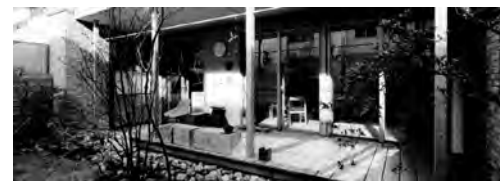
内二ワから広縁をみる。アジャスターボルトで立つ自立柱が木造住宅の軒下空間のような半屋外空間をつくりだす。
