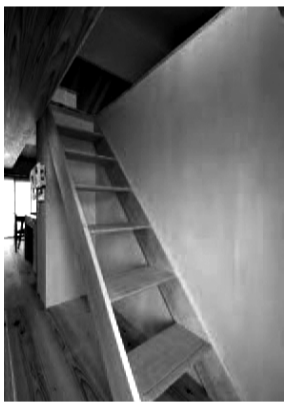
ロフト階段はハシゴとして取り外しできるような設置
