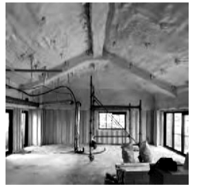
スケルトン解体後、天井と壁に付加断熱を行った空間を取りつつ家族3人それぞれの個室を確保、家中ほとんど温度差のない空間を実現できた。マンション最上階は夏の暑さから敬遠されがちだが、性能向上とプランの工夫により戸建てでは得られない風通しと眺望を持つ空に浮かぶ平屋住宅とすることができた。
