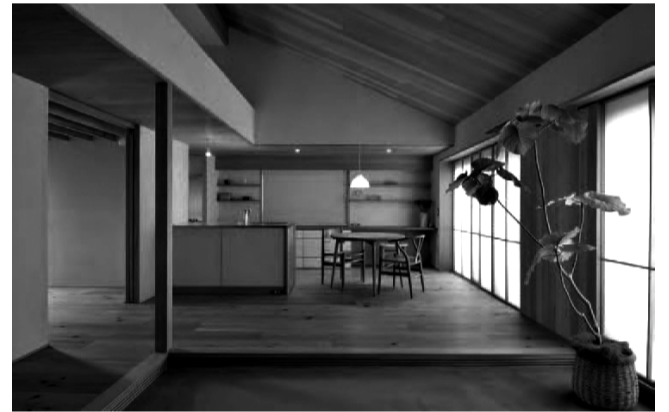
無垢の木材を張った勾配天井のあるリビング。左上がロフト。寄棟で屋根が一部下がっていたところは天井高を抑えたキッチンとダイニングに
