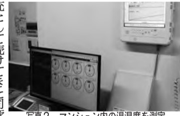
写真2 マンション内の温度を測定
