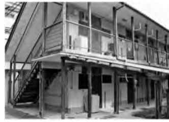
築63年木造賃貸アパート リフォーム前建物
