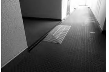
仕様通りに施工された防水シート
