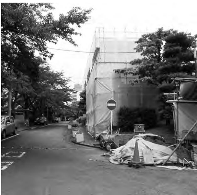
足場(仮設)の組み方にも仕様書がある
