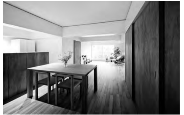
リビングとダイニングの間の梁は、既存の梁を配線スペース分だけ、少しふかして、ボードで仕上げた。それ以外の梁は、設備スペースになっている
