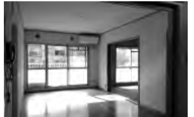
リビングとダイニングの間の梁は、既存の梁を配線スペース分だけ、少しふかして、ボードで仕上げた。それ以外の梁は、設備スペースになっている
