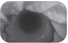
施工後 抗菌塗装された排水管として再生
