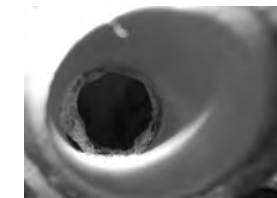
①築35年の給水用塩ビライニング鋼管内部
