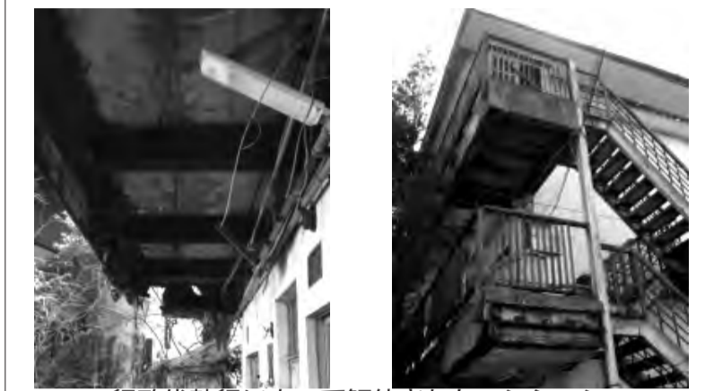
行政代執行によって解体されたマンション (資料提供: 滋賀県野洲市20年3月23日)
