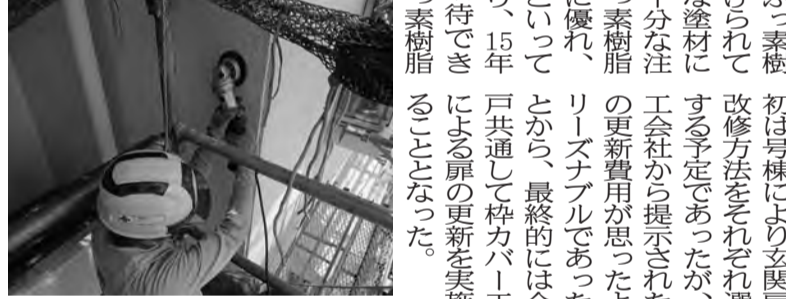
既存塗膜表面の目荒し作業
