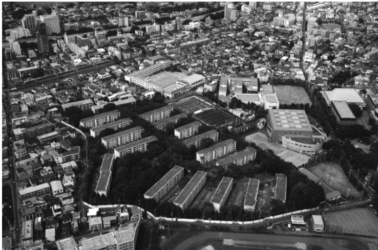
旧桜上水住宅団地 (「桜上水団地建替事業の記録」16年から)
