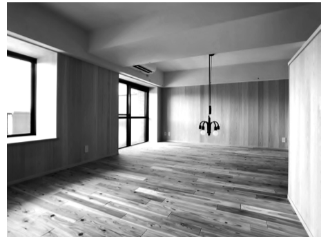
LD。床は裸足が気持ちよい杉板、垂れ壁と天井はチャフウォール
