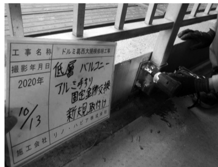
手すり固定金物取替工事
