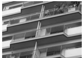
写真1 補強された中間階バルコニー
