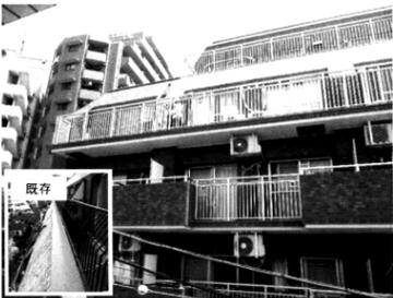
写真2: 鉄パイプ製手すりをアルミ製手すりに更新
