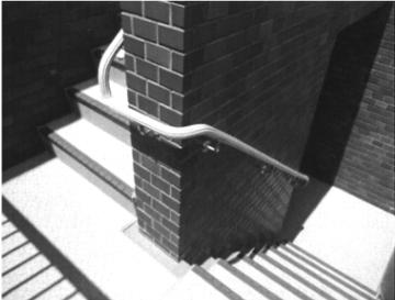
写真4: 外部階段の床塩ビシート張り補助手すりの設置
