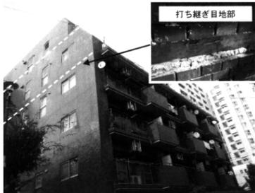
写真1: 止水処理を施した打ち継ぎ目地部
