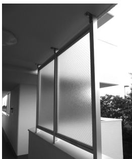
新設防風板取り付け後
