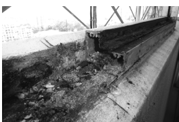
既存防風板の撤去
