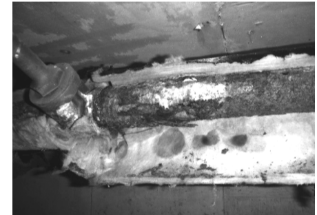
↑更新前の1階床下給水主管(外面被覆が著しく破裂寸前の状態であった)
