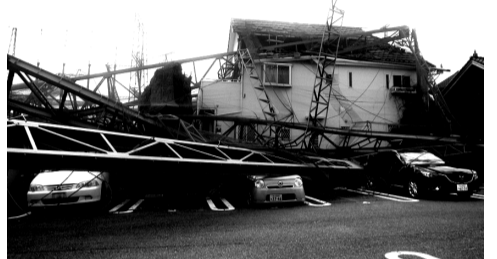
ゴルフ練習場のネット支柱が倒れ、損傷した住宅と乗用車＝千葉県市原市で
