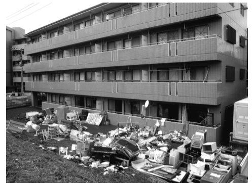
19号台風で、住民が犠牲になった4階建てマンション＝川崎市高津区溝口で
