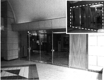
写真2：エントランスホール両開扉(右上)を引分け自動扉に改良
