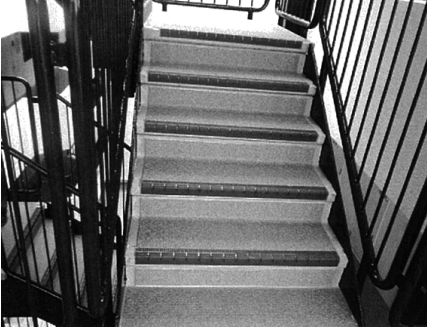
写真4：P C a板踏板と踊り場の長尺塩ビシート張り
