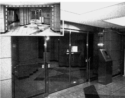
写真3：エントランスホールの自動扉と操作盤の移設
