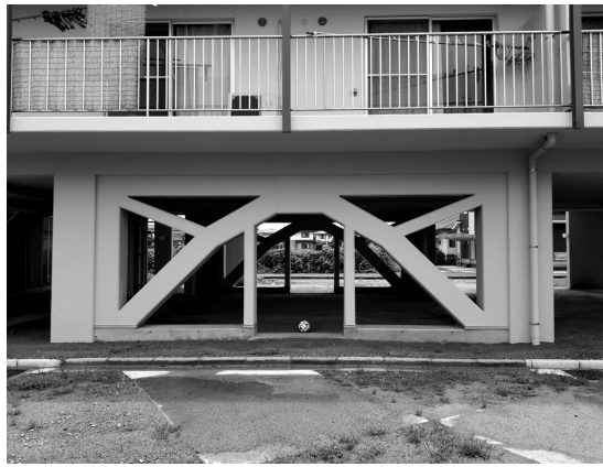
熊本地震で被災したが、耐震補強工事で復旧した市営住宅＝熊本県宇土市入地町入地団地一号楼(一級建築士の三木剛氏提供)
