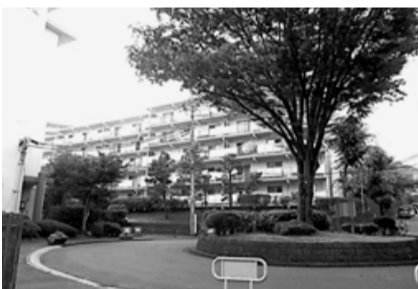
融資を受けて工事を行った鷺尾第二住宅
