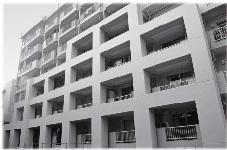
練馬区マンション 耐震補強工事
