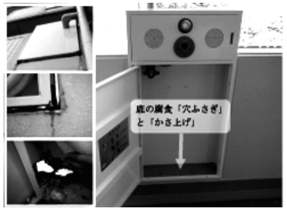
写真② 外部廊下に設置されている消火栓箱の改良
