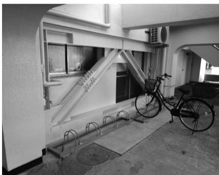
鉄骨枠付きブレース
