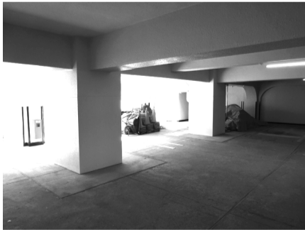
1階ピロティ柱のコンクリート巻
