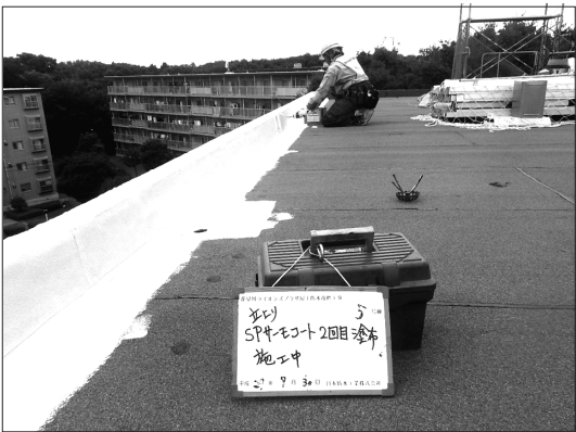
工事中の花見川ライオンズプラザ
