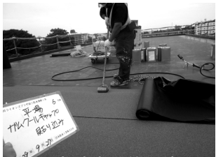
屋上防水改修工事
