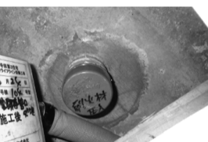
2階からの排水管撤去後
