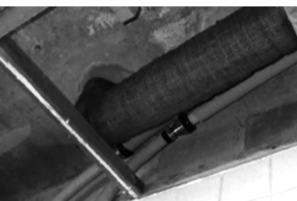
2階住戸からの排水管
