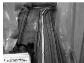
更新後住戸床下配管
