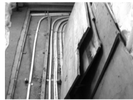
更新前住戸床下配管
