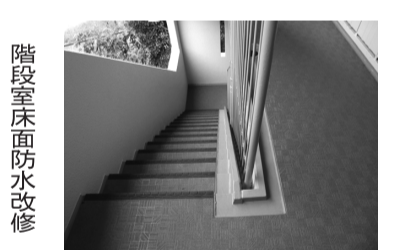
階段室床面防水改修
