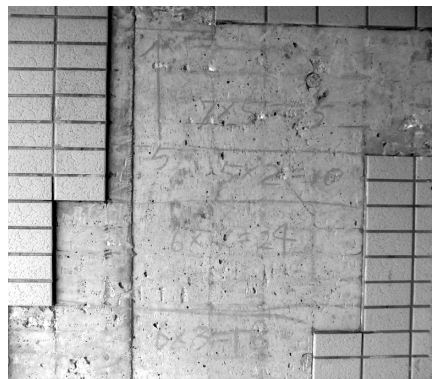
外壁タイルのはがれ
