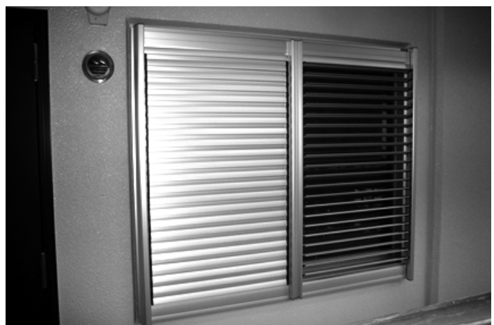
施工後：あんみつ面格子
