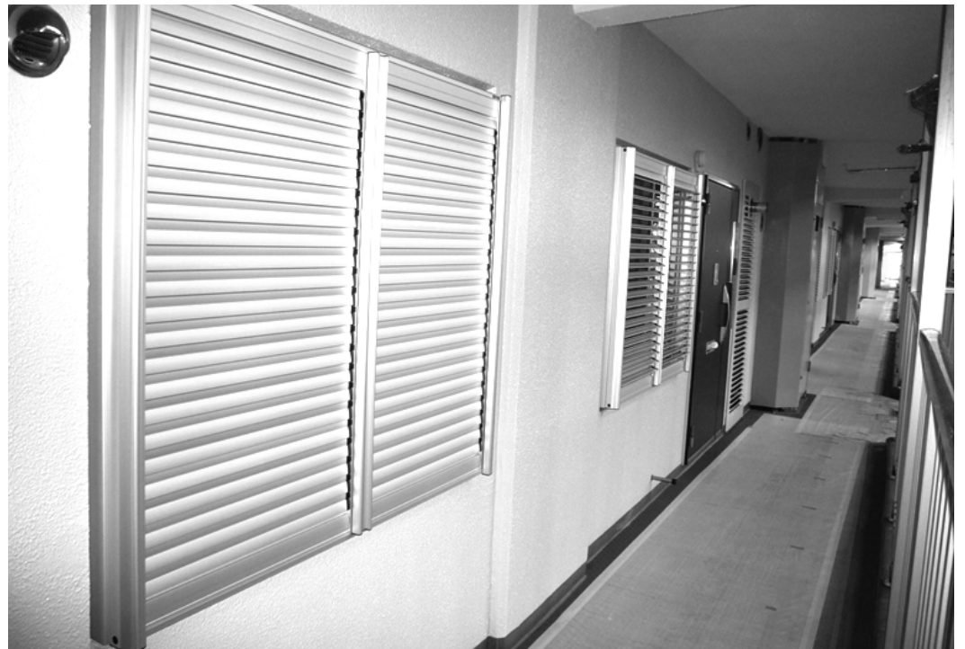
通路側を「あんみつ面格子」に取り替えたマンション
