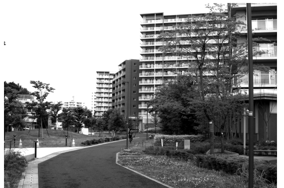
諏訪2丁目住宅建替え多摩市諏訪2丁目、旧公団5階建て、1971年分譲、23棟、3D K、管理組合20年余前から、建替え計画を進め、折ししかけたが、建替えを実現した。同東京建物グループが事業を引き受け、平成23年10月～25年10月が施工期間。
