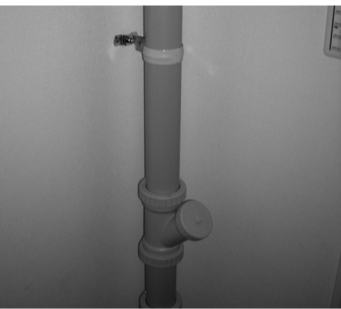
更新された洗面所排水管
