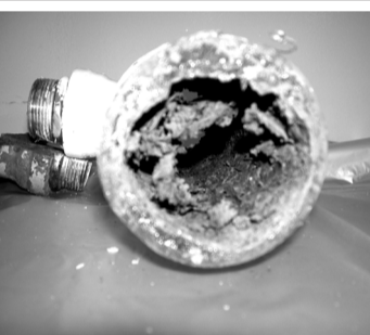
旧雑排水管の断面
