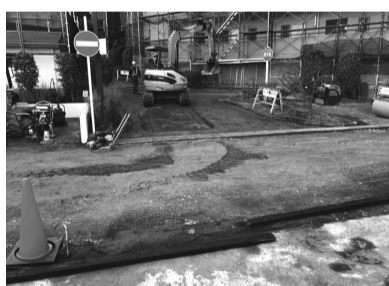
アスファルト舗装改修
