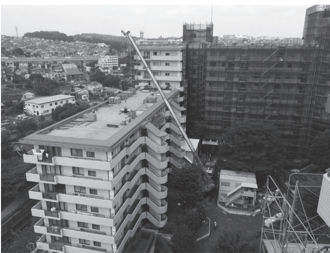
足場仮設(かしわ台クララルテ)
