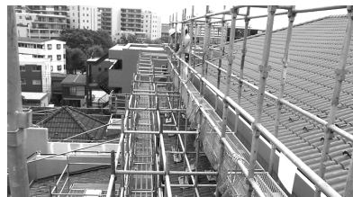
右側6階屋根は葺替済、左側4・5階屋根は葺替前
