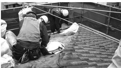
既存瓦の撤去状況
