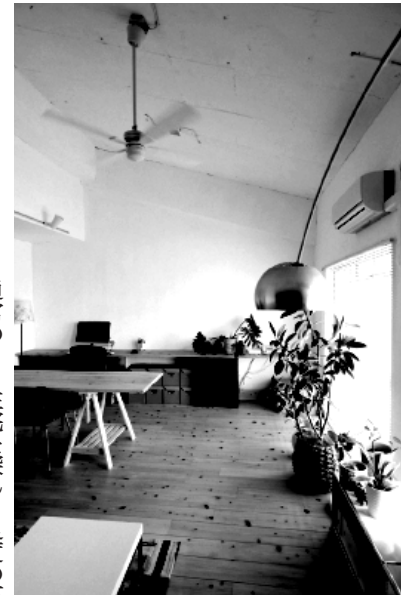
壁面は珪藻土塗り、天井 スラブ面は白に塗装
