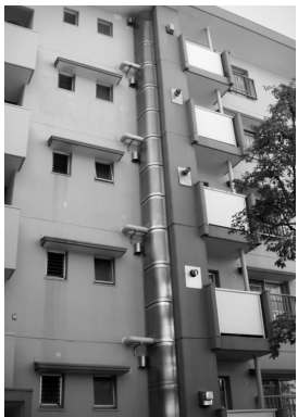
部屋を広くするために排水立て管2本分を外部化した棟
