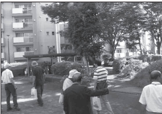
工事見学会のあった霧が丘グリーンタウン第一住宅
