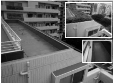
(写真2) 植栽を撤去し、花壇内防水を更新しネットを設置
