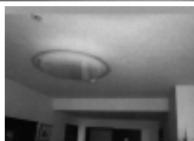
リフォーム前のリビング天井
