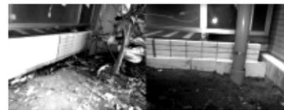
写真-5 建物廻りの地盤沈下部に土留め壁を設置
