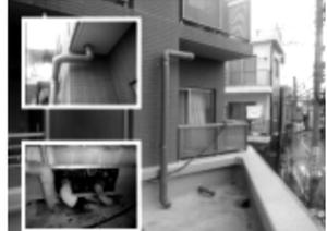
写真-3 防水層を貫通する排水管の経路を変更
