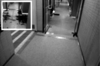
写真-4 EVホール床に排水溝を設置
