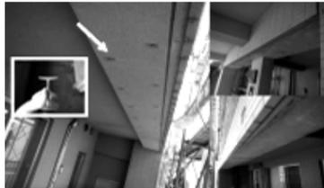
写真-2 梁底モルタルをガードピン工法で予防保全
