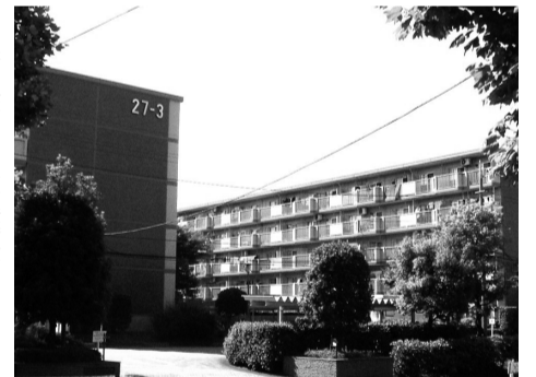
給排水管更新工事中、賃貸住戸を借りて、住民が一時利用する霧が丘グリーンタウン第一住宅=横浜市緑区霧が丘で
