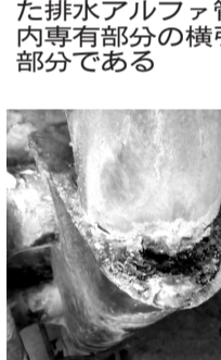
腐食により穴があいていた排水アルファ管。住戸内専有部分の横引き管の部分である
