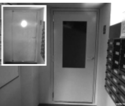
窓付防火扉に交換
