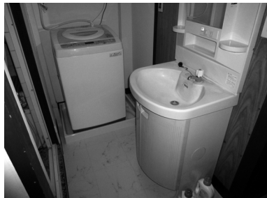
洗面所改修後 排水立管無し 洗面台と洗濯機入れ替え設置
