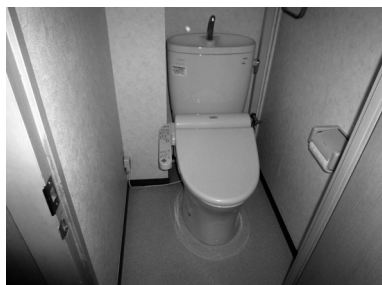
便所改修後 排水立管隠蔽 便器位置少し移動
