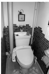
便所改修前 排水立管露出
