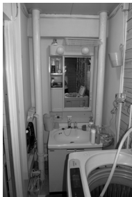
洗面所改修前 洗面台両脇の立管
