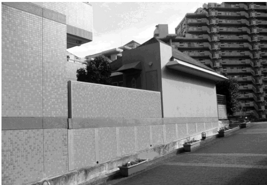
ハラス管理の修繕実施は分譲棟と非住宅棟に分れる場合などである。ただし棟数の認定が困難な場合も生じる。構造的に独立して居ても、階段エレベーターが片方に無ければ棟として独立は不可能である。では両方にあったら2棟と認定する場合は状況次第で解釈が分かれやすい。
