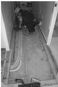
廊下の床を外しての給水管、給湯管の撤去作業
