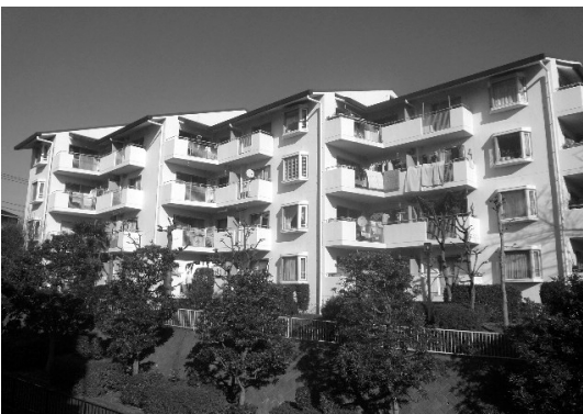
給排水管など配管設備更新を実施したすすき野第三住宅
