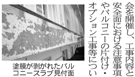
塗膜が剥がれたバルコニースラブ見付面
