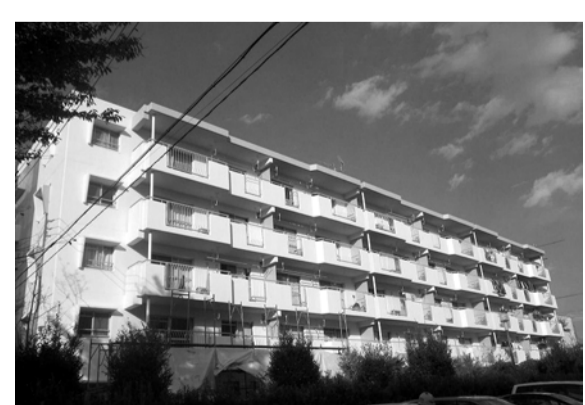
足場がとれて綺麗に完成した南面外観
