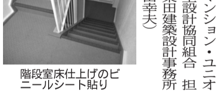
階段室床仕上げのビニールシート貼り
