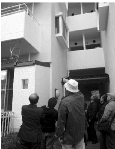
竣工した外断熱の外壁 多摩市鶴牧で
