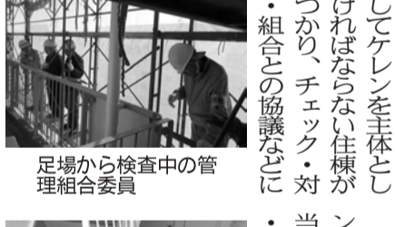
足場から検査中の管理組合委員
