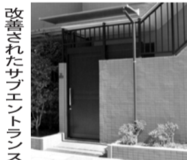
改善されたサブエントランス
