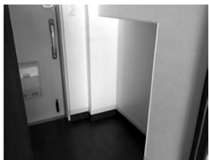
車イスのスペースを確保した玄関
