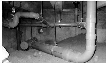
1Fピット内雑排水管取替え
