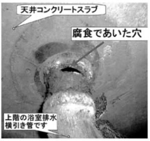
写真① 浴室天井横引き排水管の腐蝕
