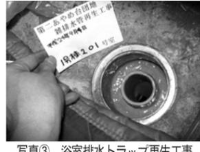
写真③ 浴室排水トラップ再生工事
