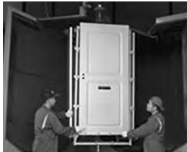
工場で改修するので焼付け塗装が可能に
