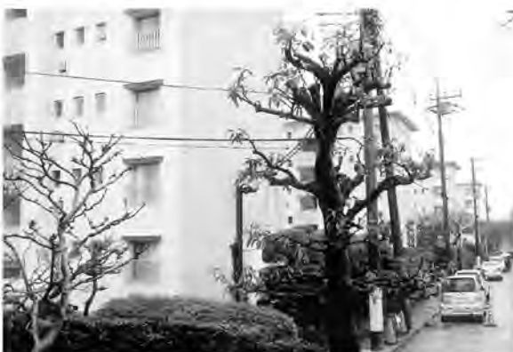
工事見学会があった花見川住宅
