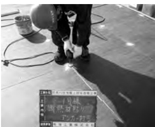
断熱材貼りアンカー打ち
