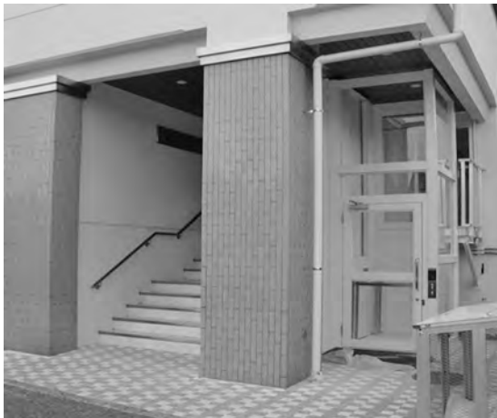
段差解消のため設置された段差解消機
