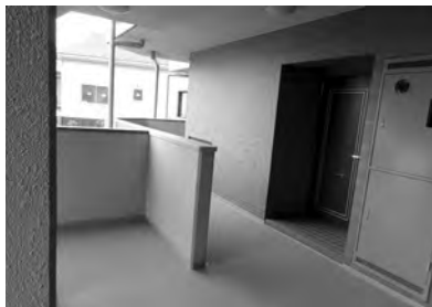
工事後の開放廊下
