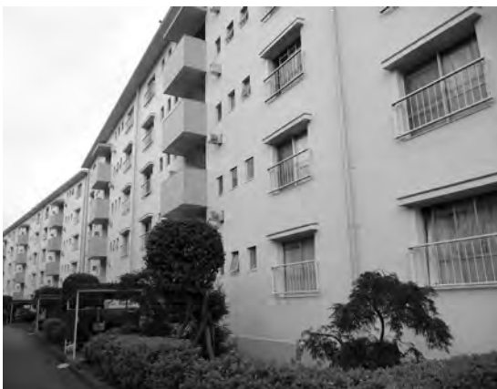
工事を終えた草加旭町住宅
