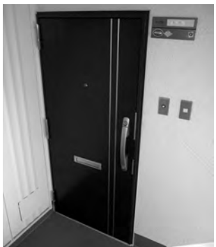
カバー工法による玄関扉取替え
