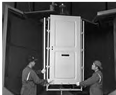
工場できれいに改修するので 焼付け塗装が可能に
