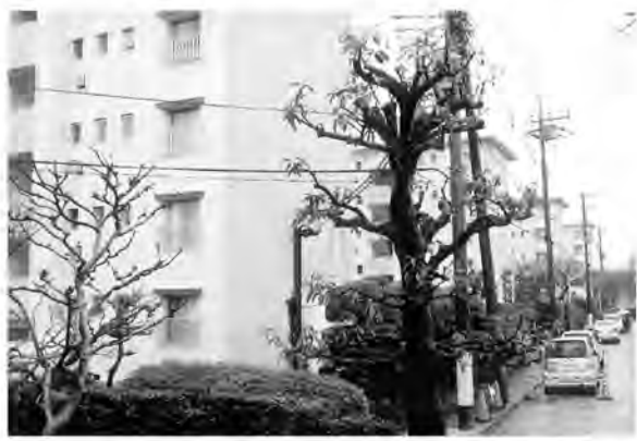
工事見学会があった花見川住宅
